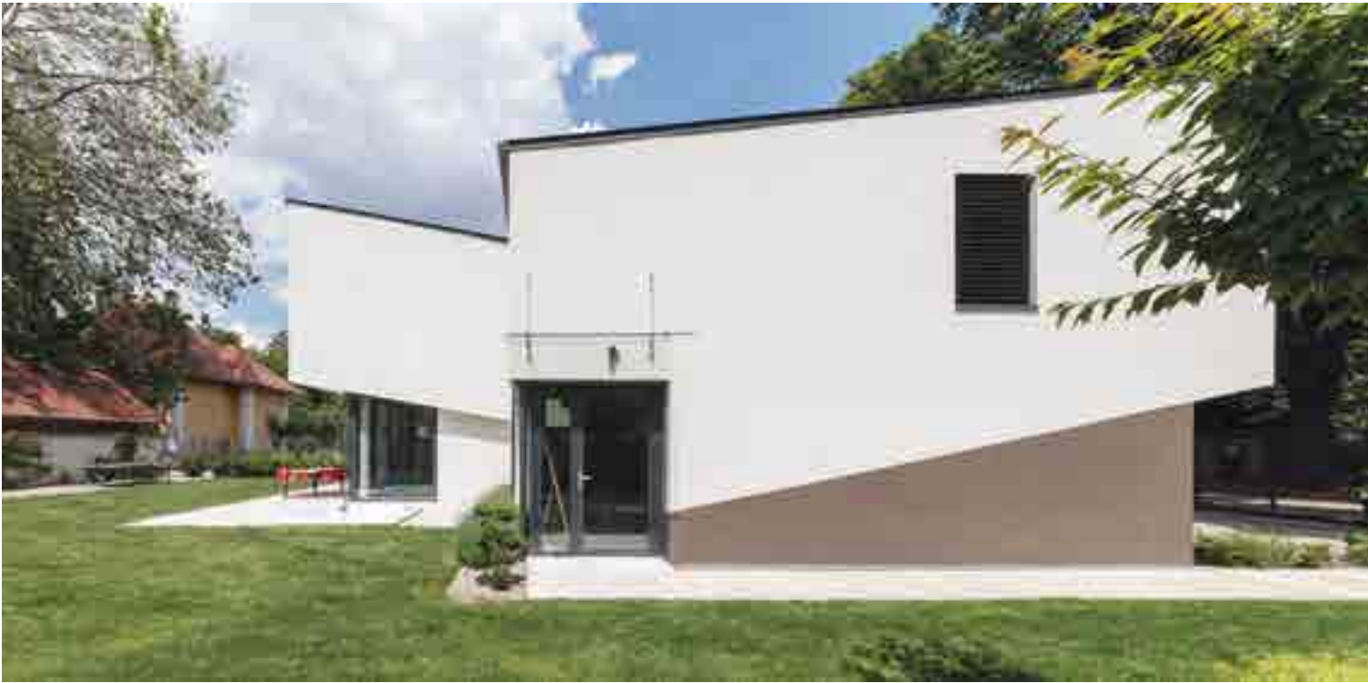
A déli homlokzati oldal a főbejáráttal
