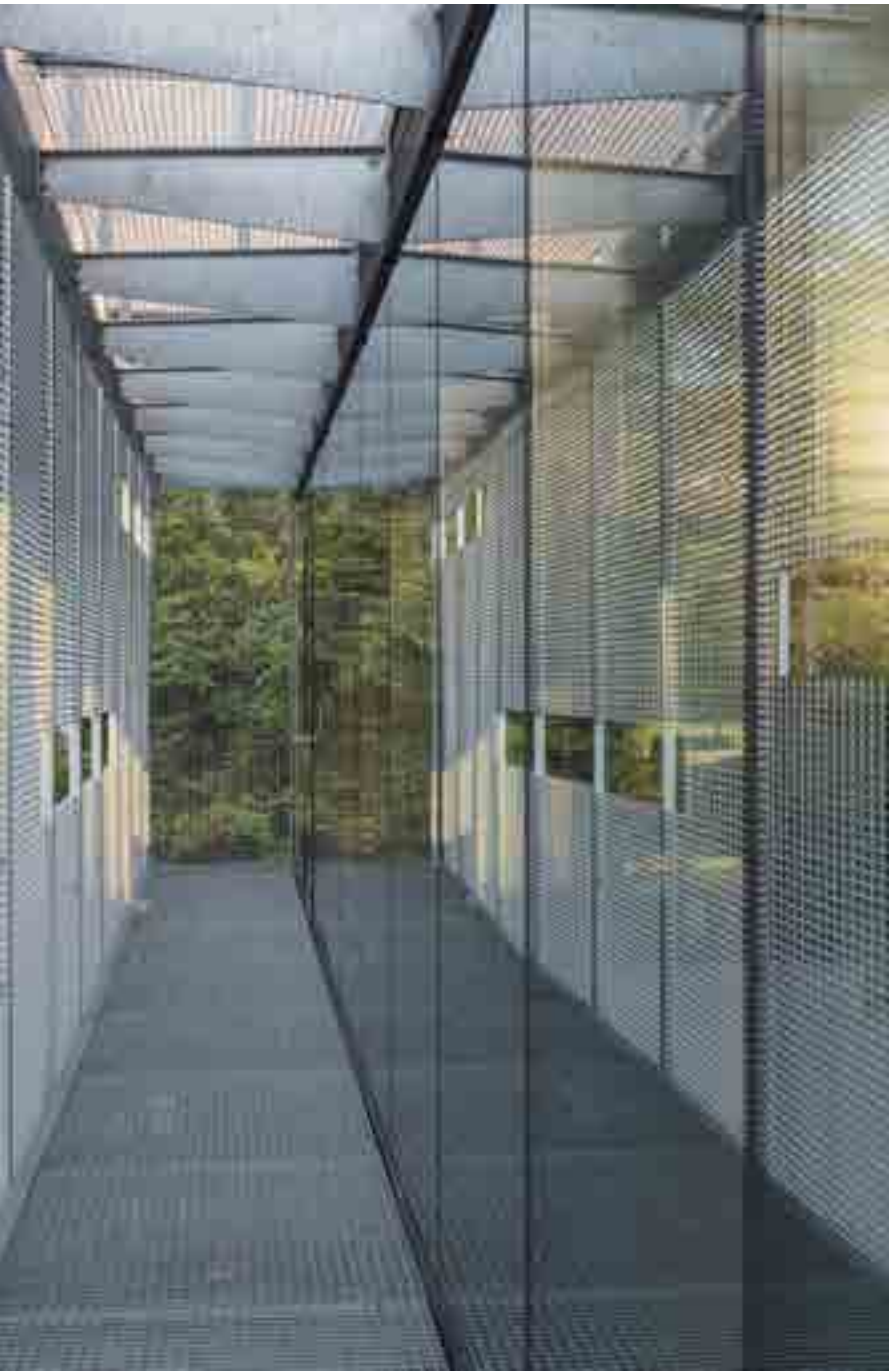
^ A fém tartókonzolok egy teraszként, kerengőként is használható taposórácsos járdát tartanak
