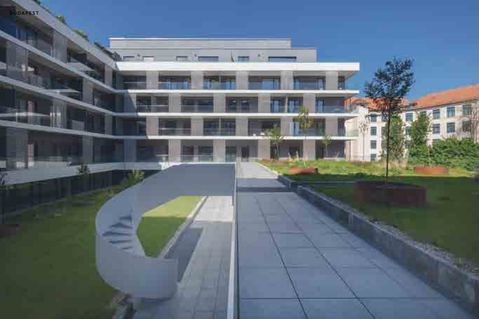
A földszinti Lidl tetejét zöldtetőként alakították ki, amely az irodaszinttel közvetlen kapcsolatban áll
